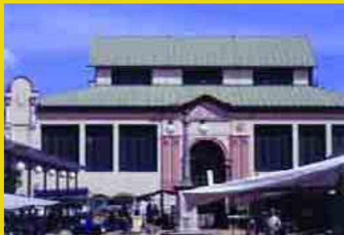
Rehabilitación de cubierta de un mercado
