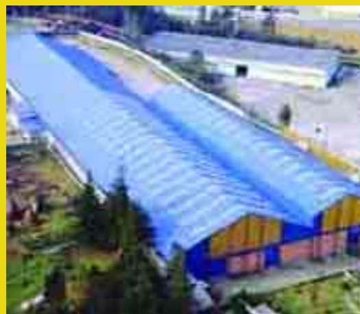
38 Cubierta y fachada de nave industrial
