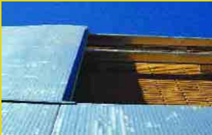
Fachada rehabilitada con paneles por el exterior
